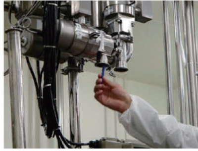
照片4 ATP荧光检测的活用事例1 必须检查生产线在使用前和CIP清洗后的清洁度 (对难以清洗、不易看见的地方等场所进行涂抹检测)
