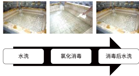
照片 6-4 PC 法的步骤：④水洗~消毒
