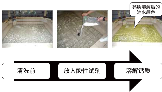
照片 6-1 PC 法的步骤：①酸性清洗
