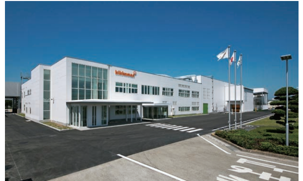
照片 1 Kikkoman Soyfoods Company 茨城工厂(占地面积约为 38000 平方米;建筑总面积约为 19000 平方米;产能约为 90000 盒/天;员工人数截至 2014 年 3 月约为 60 人。)
